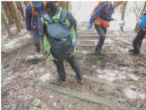
階段設備の点検 (大平山にて)
