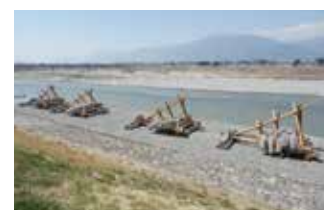
聖牛(洪水の流れを弱める古い河川工法。木材を三角に組み立て蛇籠に石を詰めて載せたもの)
