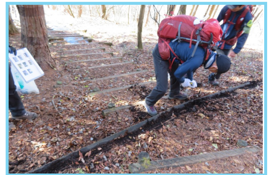
＜定期点検(11月10日)@大平山＞
