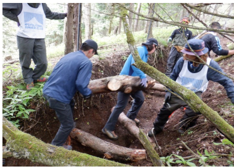
登山道補修作業@石割山
