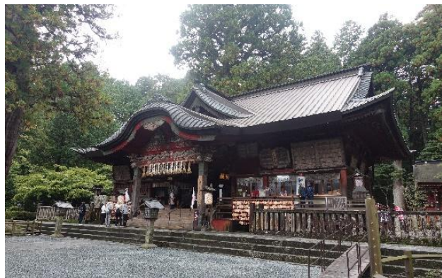
写真3 北口本宮富士浅間神社の拝殿・幣殿 大正の修築の結果、銅板葺になっており、玉垣で囲まれている。
